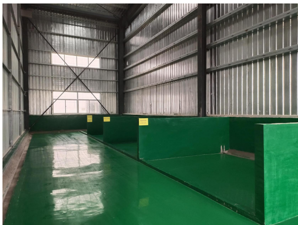
地面、围堰防渗
