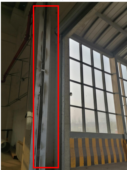
垃圾卸料平台入口风幕
